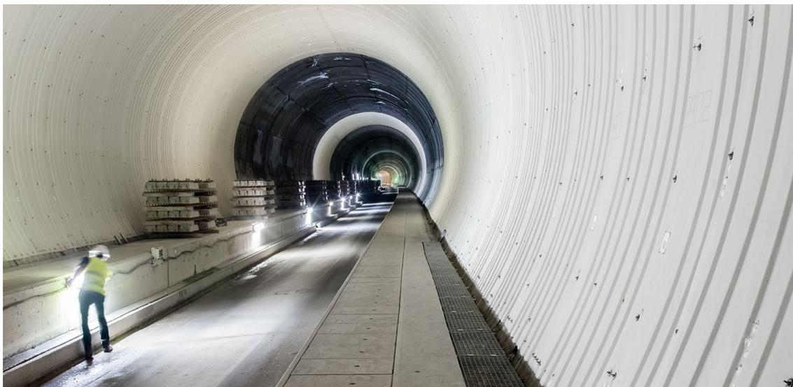
**Figura 4.** Tramo de túnel impermeabilizado
