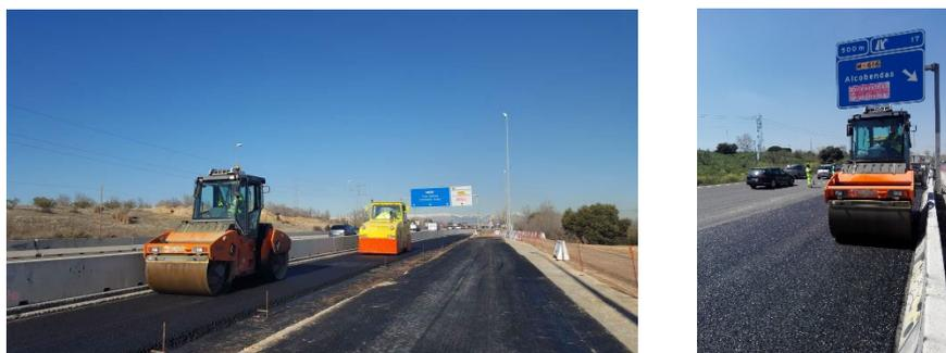
**Figura 11:** Ejecución de la capa intermedia (izquierda) y rodadura (derecha)
