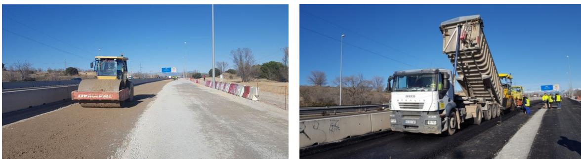
**Figura 10:** Ejecución de la capa de base (izquierda) y subbase (derecha)
